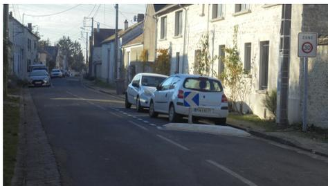
Au printemps dernier, les agents ont réalisé la mise en place de la zone limitée à 30 km/h, rue Laurent Poli : création de 5 îlots de rétrécissement de voirie, marquage au sol des emplacements de stationnement et signalisation.
